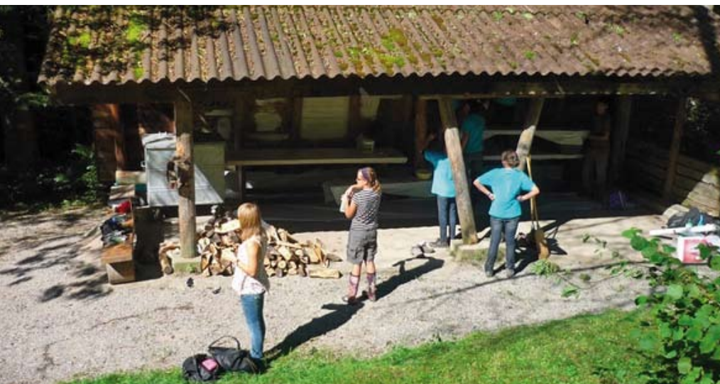
Die versprayte Waldhütte wurde abgeschliffen, neu grundiert und verziert.
